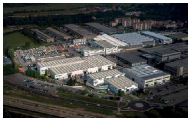
IMPIANTI DI PRODUZIONE
